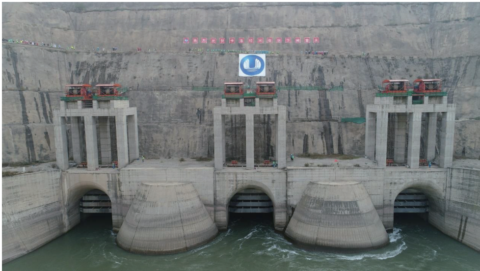
图7 卡洛特水电站下闸蓄水
